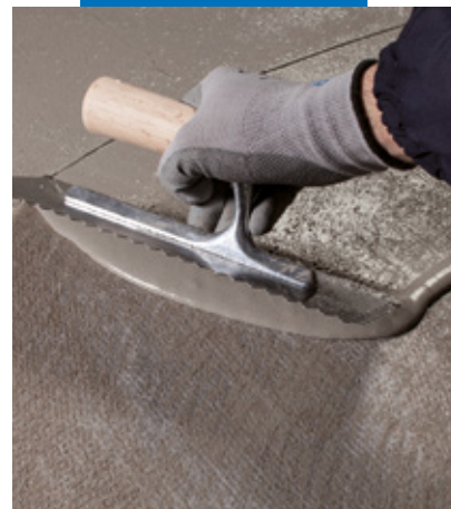
Seconda mano di Mapelastico Turbo su prima armata con Mapetex Sel
