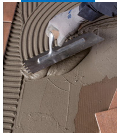
Posa di piastrelle con Elastorapid
