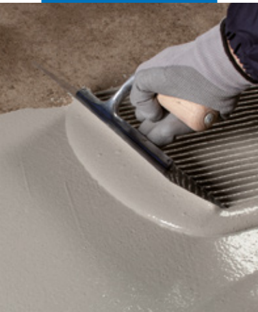
Applicazione della prima mano di Mapelastico Turbo
