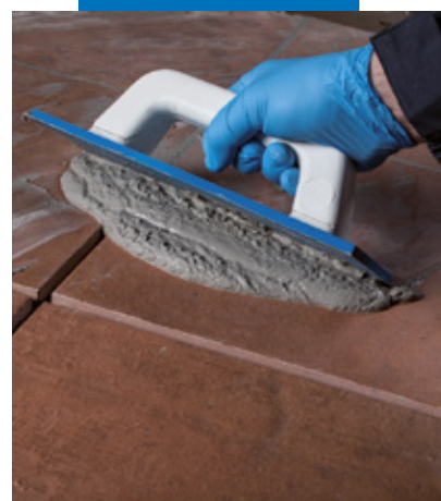
Stuccatura di piastrelle con Ultracolor Plus
