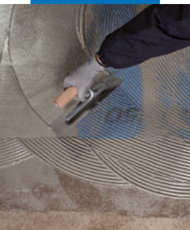
Inserimento di Mapenet 150 nella prima mano di Mapelastico Turbo fresca
