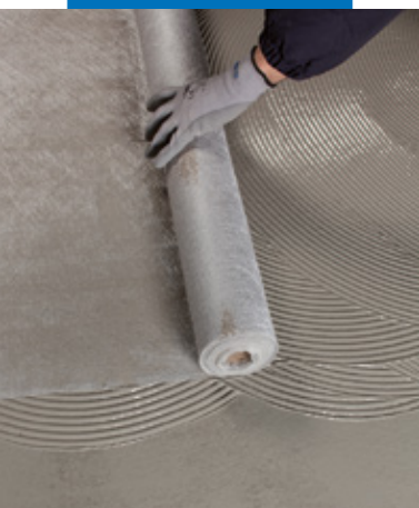
Inserimento di Mapetex Sel nella prima mano di Mapelastico Turbo fresca
