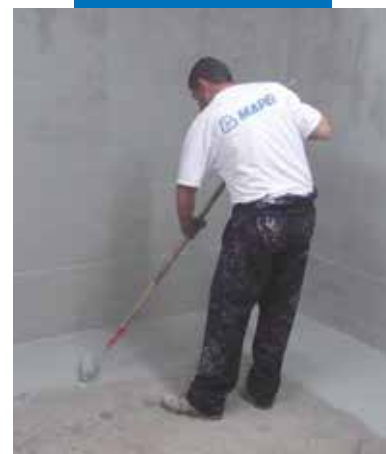
Mapelastic Foundation steso a rullo in un intervento di impermeabilizzazione in contropinta
