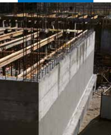
Muro controterra impermeabilizzato in post-getto con Mapelastic Foundation
