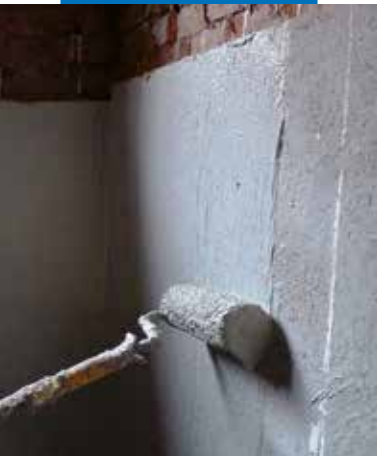
Applicazione di Mapelastic Foundation a rullo su supporto precedentemente regolarizzato con Planitop HDM Maxi
