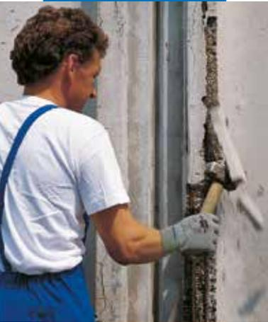
Demolizione del calcestruzzo degradato
